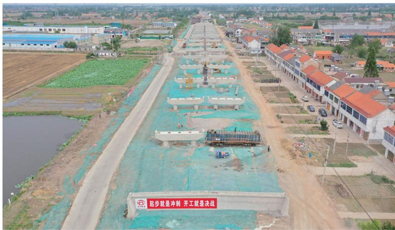
6月23日，由集团承建的盐阜2标人民路跨线桥最后一道盖梁施工完成，至此，人民路跨线桥率先进入上部结构施工阶段。盐阜2标全线需改建33座大中小桥，施工点分散，施工难度较大。目前完成全线桩基施工94.6%，承台施工80.9%，其他构件正在紧锣密鼓地浇筑。
