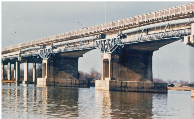
委员会与鲁沪输油管道工程指挥部联合召开会议，研究确定由石油化工部和江苏省交通局共同投资、省第三工程处（集团公司前身）参与建设，在盱眙县北、淮河流域进洪泽湖的入口处修建一座跨淮河的油管公路两用桥，这样既满足鲁沪输油管道建设工程要求，又能改善洪泽湖以西的公路交通条件，还节省造价，可比公路桥、输油管架桥分建节约投资三分之一。
