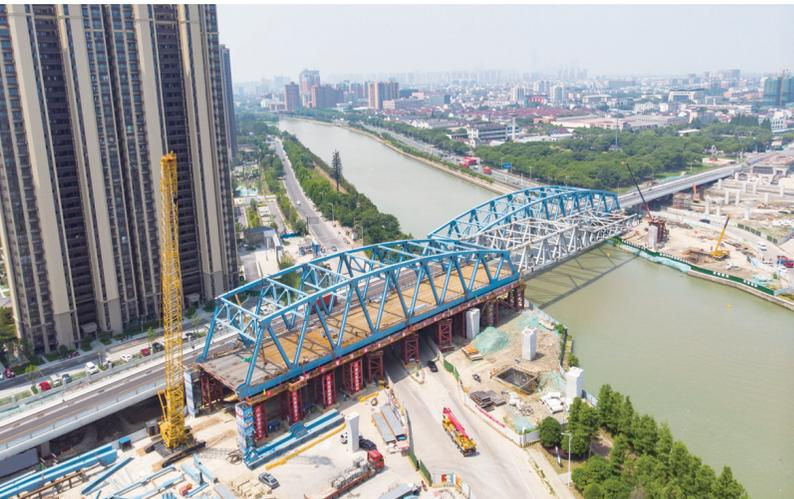
6月17日，历经4小时奋战，苏州江陵大桥主线右幅第四节段顶推完成。施工期间，面对施工难度大、京杭运河通航时间短等诸多困难，项目部多措并举、积极攻坚，最终在确保安全和质量的前提下，如期完成拼装和顶推上架工程。
