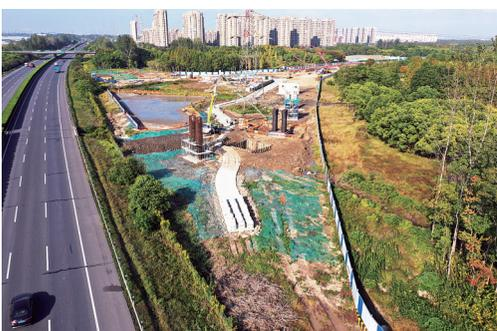
10月24日,沪宜高速金仓湖互通工程施工现场,机械隆隆作响,工人忙碌不停,路基填筑、承台浇筑等各项工作有序进行。金仓湖互通建成后将成为连接沪宜高速与太仓市区最便捷的通道,极大减轻双凤互通及204国道的交通压力。秋季“黄金期”,项目“战正酣”,全体建设者开足马力,为11月初进入高速区域施工做好万全准备。
