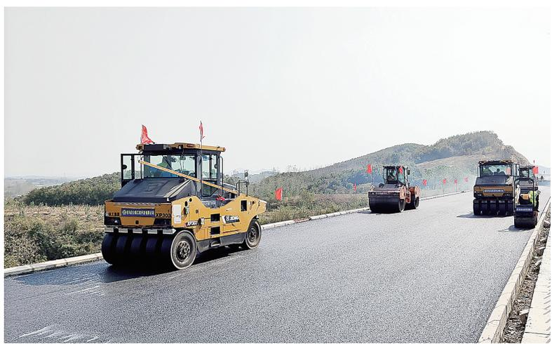
10月16日,许信高速8标路面项目在桩号ZK141+970-ZK142+330左幅进行了AC-20C沥青中面层首件试铺施工。为确保试铺工作顺利进行,施工前,项目部认真编写方案,多次研讨确认并进行了沥青中面层施工技术交底,详细落实施工细节、安全注意事项、技术要点等,确保沥青中面层首件试验段一次性成功。
