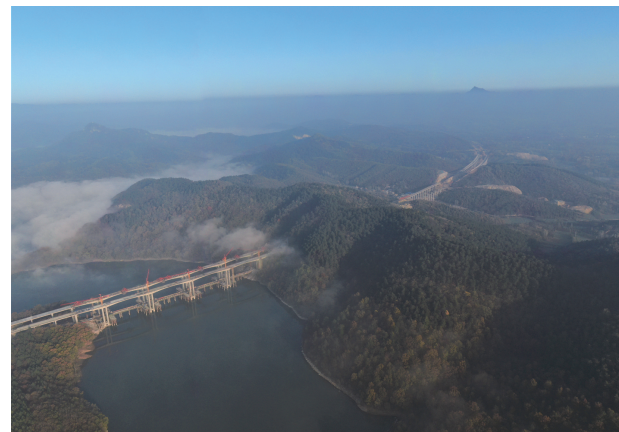
贯通的薄山一号隧道。
