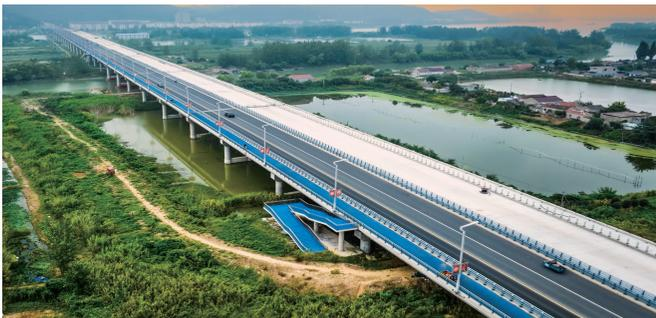
双向六车道,桥梁总宽35米,设计时速80公里。工程总长2063米,其中主桥长1530米,按公路I级标准建设,项目分为SG1标、SG2标,均由开通公司负责实施。344国道淮河大桥项目是盱眙干线内环中最为重要的组
