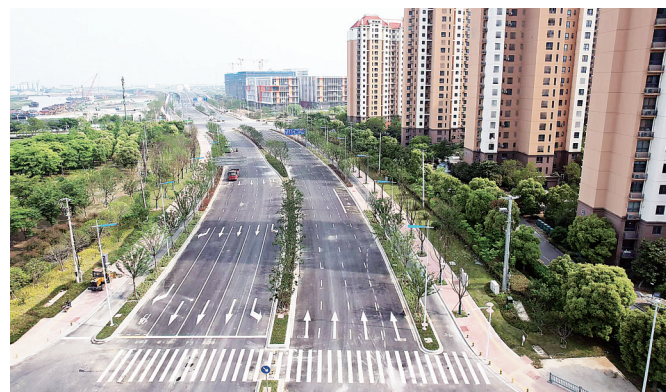
苏州星塘街项目实景。 陆缙 摄
