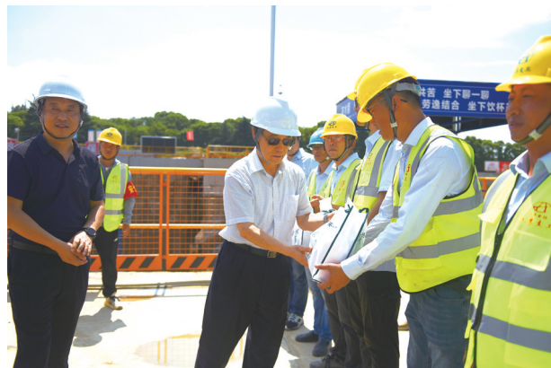
在施工现场,方建华(中)慰问一线建设者。朱东波 摄
