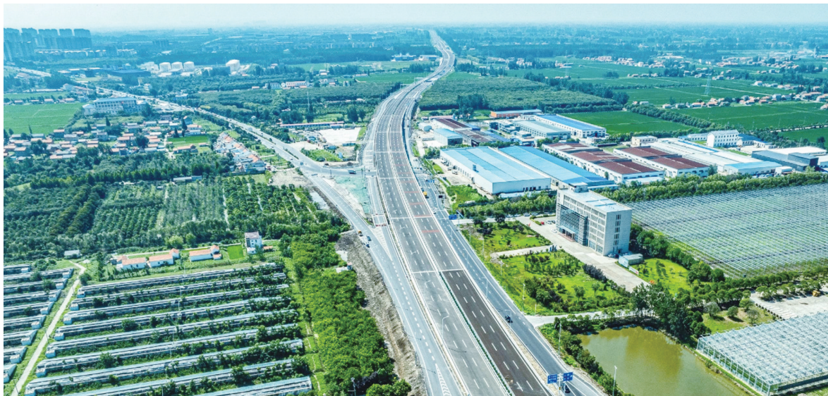
盐城204国道盐阜快速通道建成通车。 徐金亮 摄
