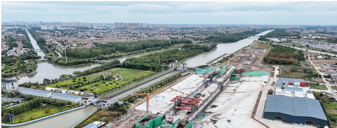
建设中的连申线大套二线船闸。
