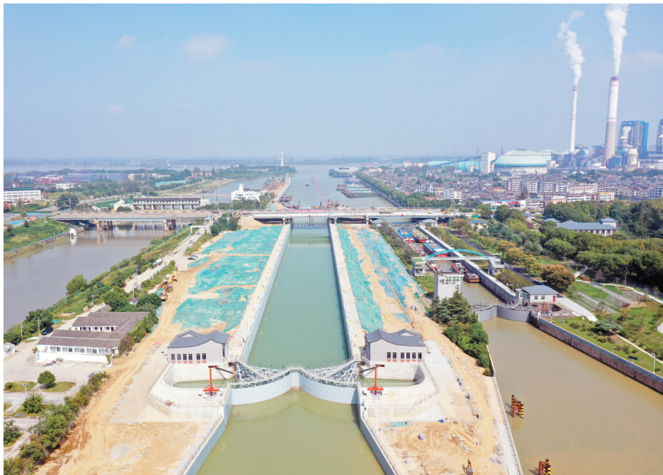
建成的项目实景。张啸龙 摄
